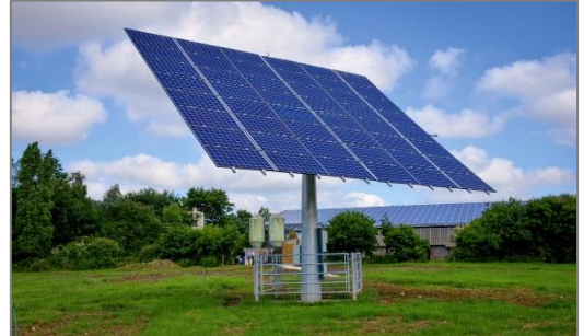
Unité solaire sur pylône avec tracker sécurisé par une barrière (Source : paysan breton)
