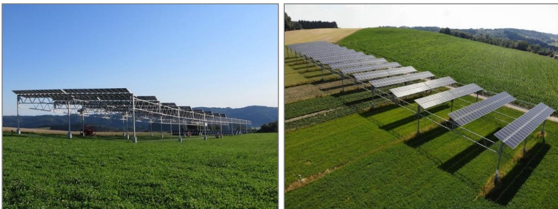
Système agrivoltaïque à Heggelbach près du lac de Constance en Allemagne (source Fraunhofer ISE)
