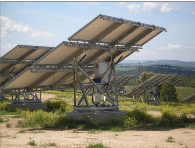
Trackers à deux axes SOLON et FEINA (Source : ENCIS Environnement)
