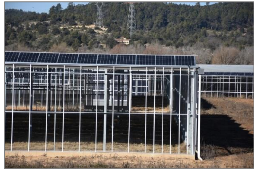
Serre photovoltaïque en construction dans le Var (Source : ENCIS Environnement)
