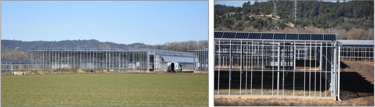
Serre photovoltaïque en construction dans le Var (Source : ENCIS Environnement)
