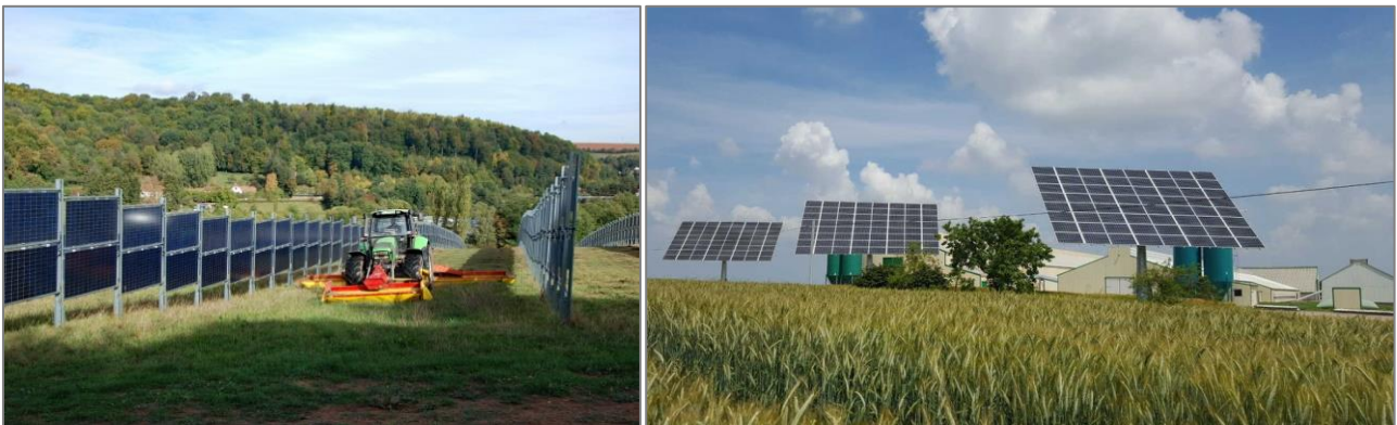
Parc photovoltaïque de Dirmingen (Source : Carolin Merkel et Next2Sun) et Exemple de panneaux « tournesol » en grande culture (Source : OKWind.fr)
