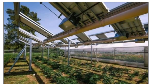
Principe Ombréa : Panneaux coulissant selon les besoins des plantes : panneaux ouverts au maximum en cas de faible luminosité et/ou de besoin réduit (situation 1), panneaux intégralement déployés pour limiter l'insolation (Ombrea)
